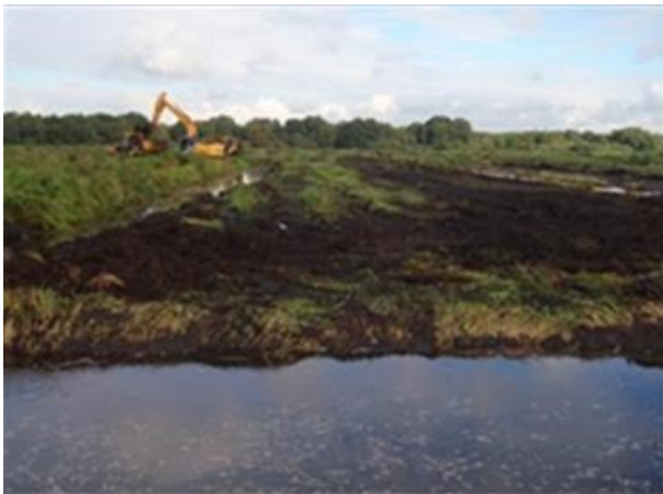
De werkzaamheden ter hoogte van het kavelpad aan de Middenweg zijn begin september 2013 begonnen.
